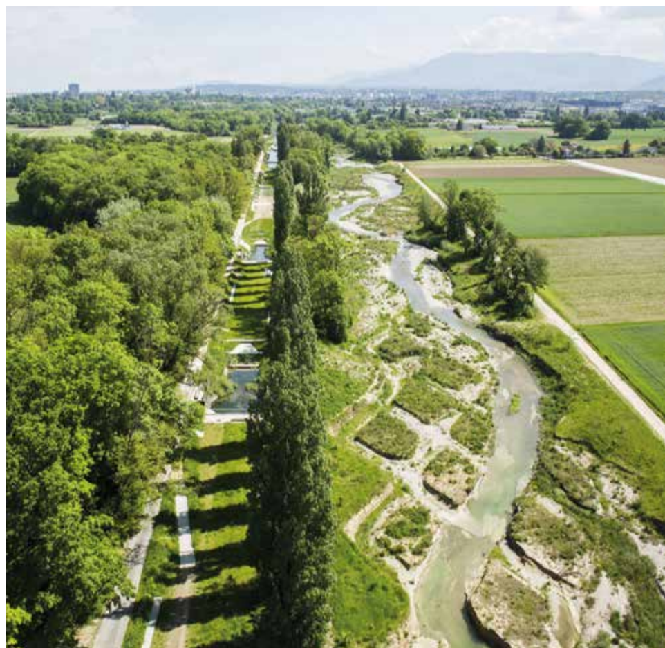
A gauche le canal réaménagé; à droite, l'Aire revitalisée
