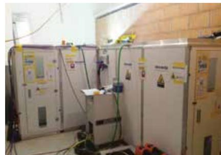
Im abgeschotteten Raum werden Saugvorrichtungen installiert. Sie lassen die mit Fasern versetzte Luft durch einen Filter, der die Gesamtheit der Fasern zurückhält, gereinigt nach draussen strömen. Am Ausgang der Saugvorrichtung befindet sich ein Rohr, das zu einem Fenster geführt werden muss, damit die gereinigte Luft entweichen kann.
