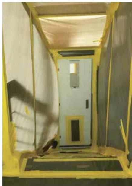
Eine Öffnung bleibt für die Dekontaminationsschleusen. Im Idealfall verlangt die SUVA eine Schleuse für den Personenverkehr zu 4 Kammern mit 2 Zo-
